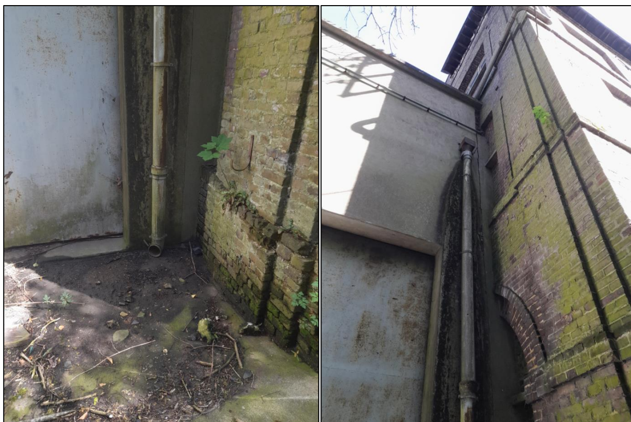
2 : Photographie de l'angle entre le bâtiment en brique et le bâtiment mitoyen – façade Sud – fissure verticale le long de la tuyauterie
