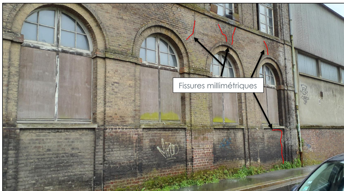
1 : Photographie de la jonction entre le bâtiment en briques et le bâtiment mitoyen – façade Nord fissure millimétrique entre les fenêtres du R.D.C et R+1 – tuyau rouillé
