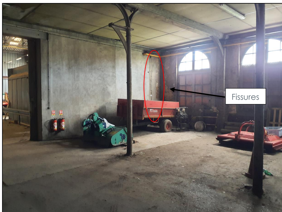
1 : Photographie du mur fissuré
