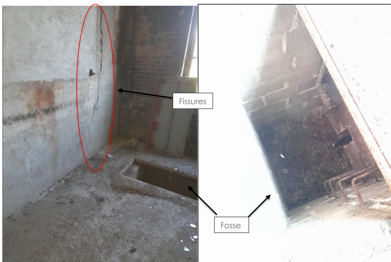
1 : Photographie de la fissure centimétrique et de la fosse
